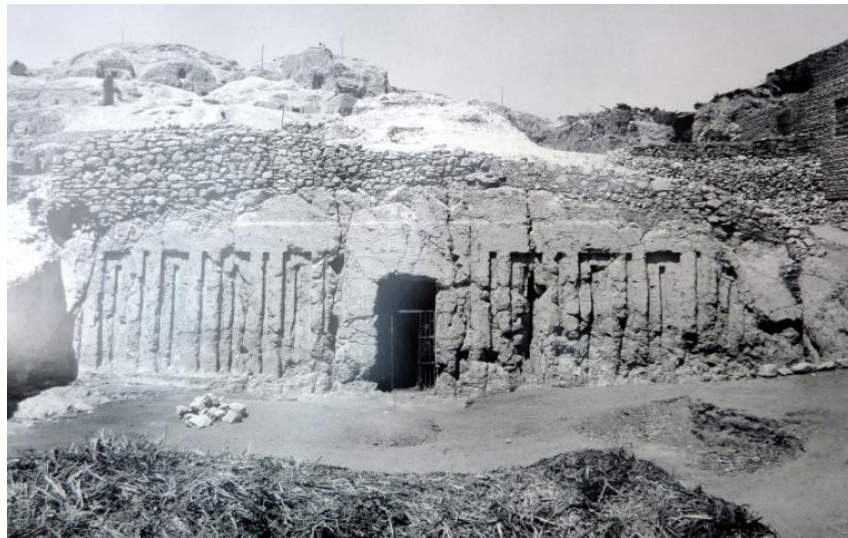
Abb. 7 Fassade des Grabes von Useramun TT 131
